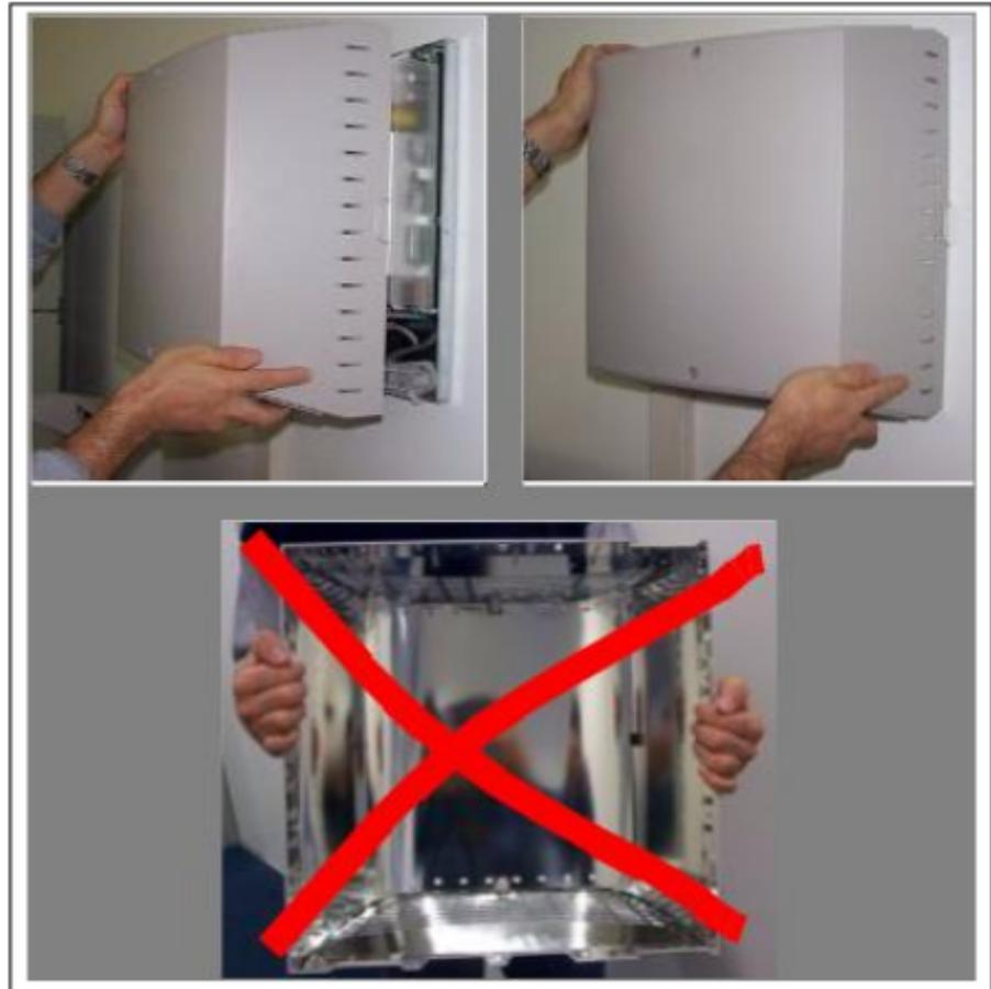
2) Sichern Sie die Gehäusekappe mit den beiden Befestigungsschrauben.
